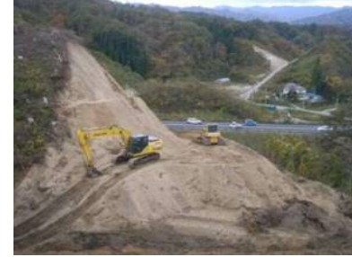
⑦施工：樋下建設
