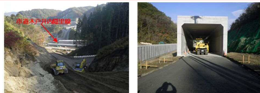
①施工：佐田建設
